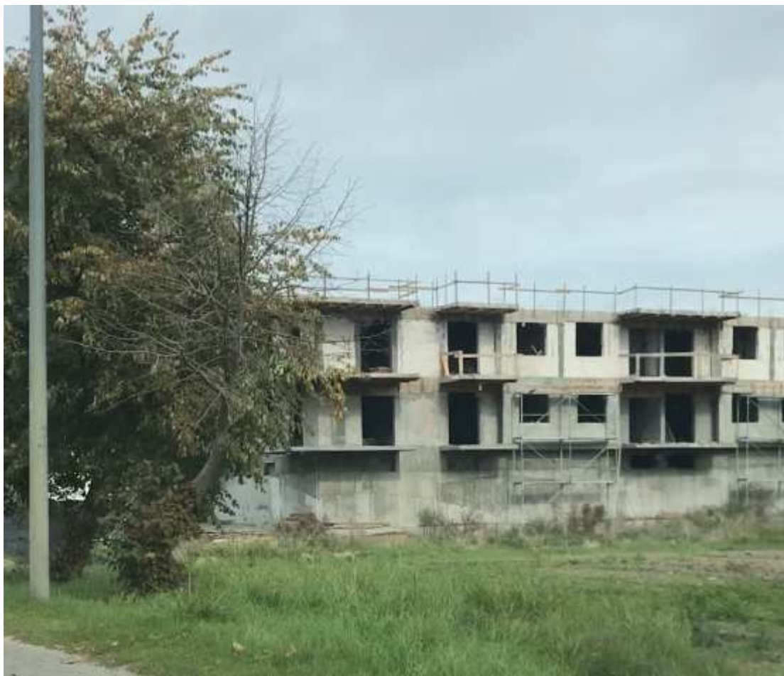
Fot. 5. Budynek wielorodzinny w budowie przy ul. Starego Urzędu nad Czerską Strugą
