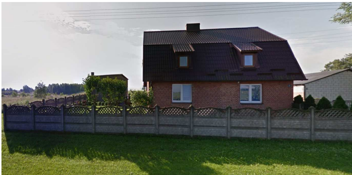
Fot. 36. Dom mieszkalny Łąg-Kolonia 6
