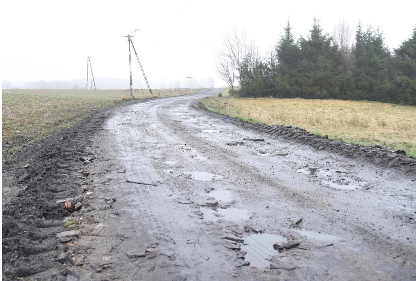
Utwardzony zostanie niespełna 500-metrowy odcinek w kierunku Budzisk.
