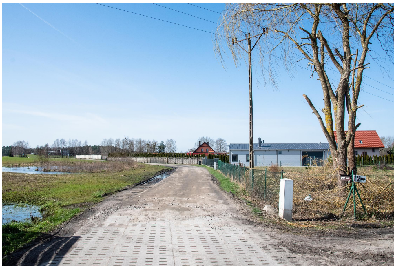
Kontynuowana będzie też budowa ulicy Szkolnej w Malachinie.
